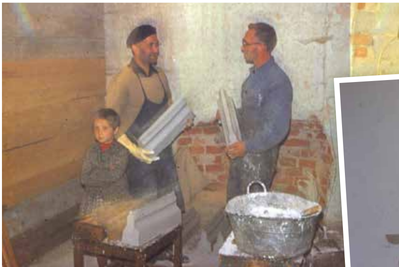
Karl Hagler und Wilhelm Lixl beim Anfertigen der Elemente für das gotische Gewölbe, Maria Hagler
