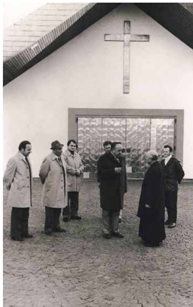
Übergabe der Aufbahnungshalle durch Bgm. Oswald Oberreiter. Am Bild v.l.: Baumeister Alois Seiringer, DI Helmut Mitter, Geschäftsführer Baufirma Schmid, Kooperator Josef Sallaberger, Bgm. Oswald Oberreiter, dahinter Polier Ernst Pramendorfer, Pfarrer Dechant Heinrich Koller, Pfarrgemeinderatsobmann Johann Wenninger
