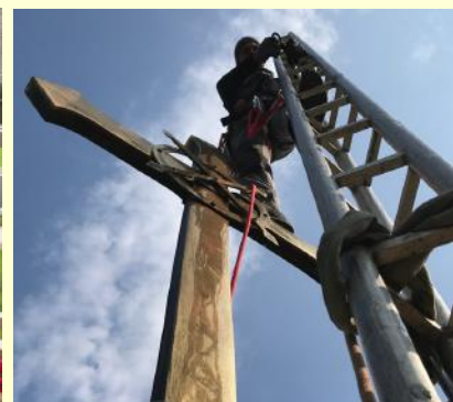
BEI DER ABMONTAGE DES ALTEN TURMKREUZES.
