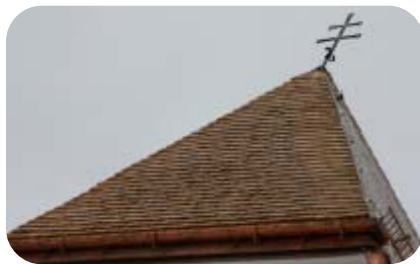
Dachdeckung, -rinnen und Verblechung sind neu.
