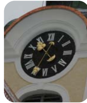
Schäden am Putz sind saniert.
