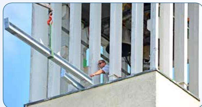
*Einbringung der neuen, massiven Stahlträger in die Glockenstube und Kraneinsatz der Firma Weber, Neuhofen, zum Austausch der rostigen Stahlträger und Montagearbeiten der schweren Glocken durch die Firma Köstner aus Engelhartzell.*
