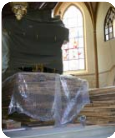
Vor wenigen Wochen: Baustelle Pfarrkirche Foto: H. Haas
