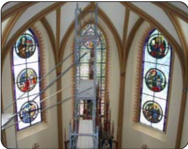
Die renovierten Fenster sind wieder eingesetzt und verändern das gewohnte Bild der letzten Jahre.
