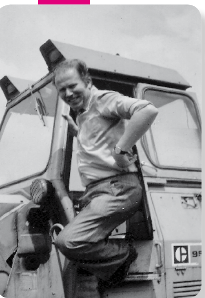
11. Mai 1981: Hans am Bagger beim Spatenstich für die neue Kirche
