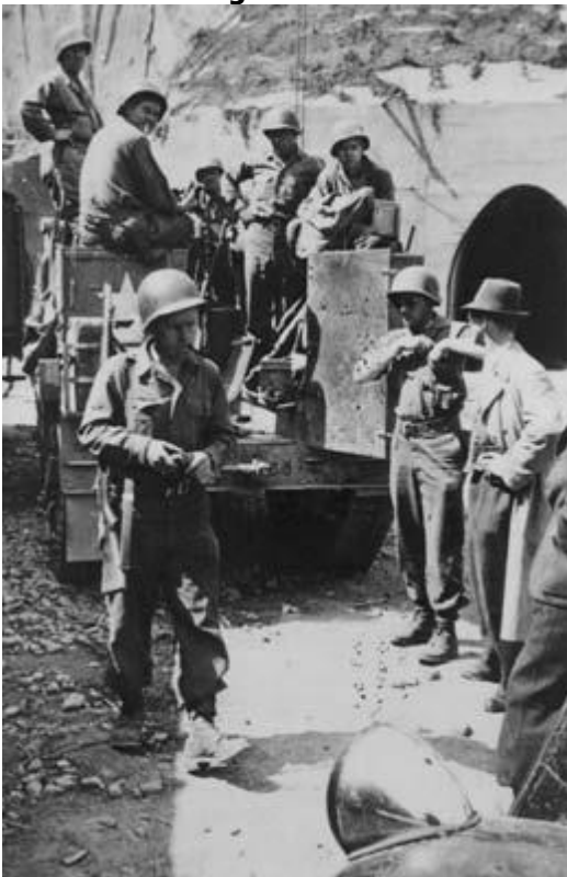
"Bergkristall"-Stollenanlagen in St. Georgen am 5. Mai 1945.
