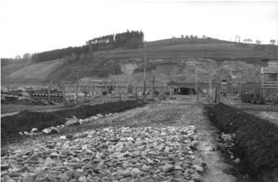
Haupteingang zum Lager vor dem Bau des "Jourhauses", Frühjahr 1940.
