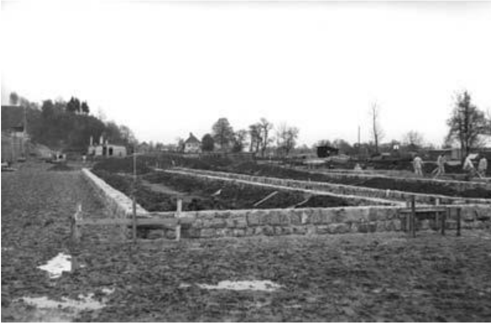
KZ-Häftlinge beim Bau von Fundamenten für SS-Baracken, Frühjahr 1940.
