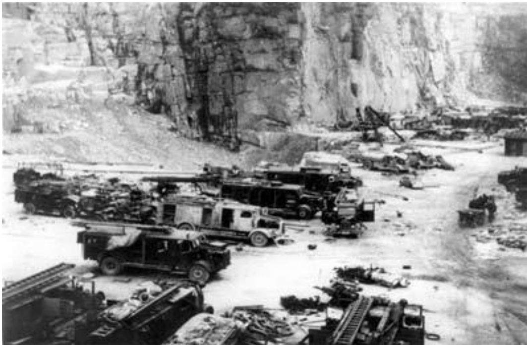
Fahrzeuge der Wiener Feuerschutzpolizei im Steinbruch Wiener Graben in Mauthausen kurz nach der Befreiung
