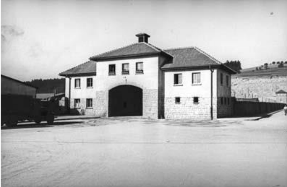
Ansicht des Jourhauses von außerhalb des Lagers, vermutlich Frühjahr 1943
