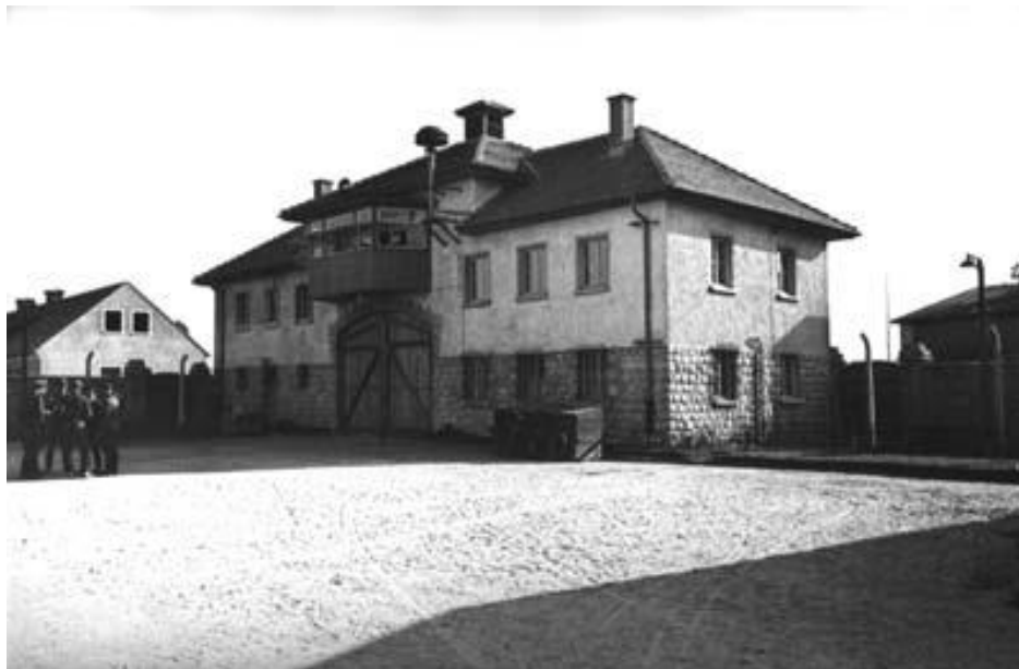
Ansicht des Jourhauses vom Innern des Schutzhaftlagers aus, vermutlich Frühjahr 1943
