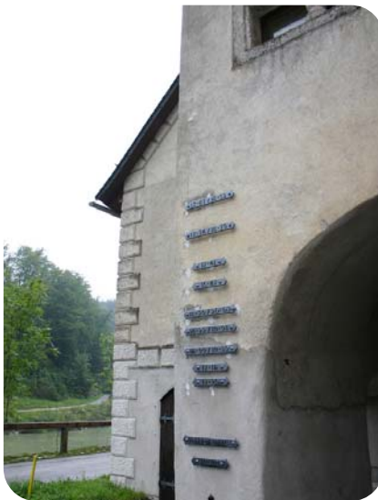
Diese Marken bezeugen viele Hochwasser an der Enns
