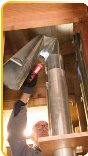
Die größte Metall-Pfeife musste repariert werden, sie war wohl amtsmüde und ist abgeknickt.
