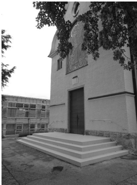
Der Haupteingang zur Pfarrkirche wurde mit Granitstufen erneuert.
