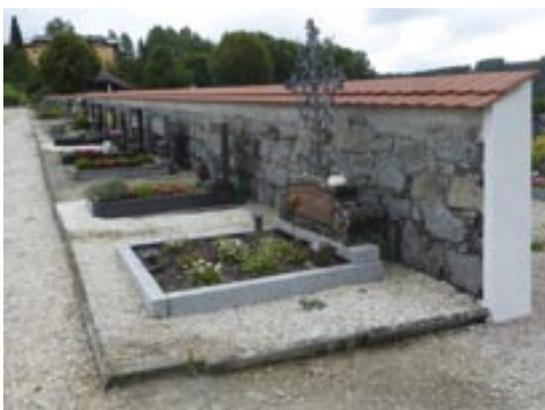
Um die Schäden, welche das eindringende Wasser in die Mauer Ritzen verursachte, zu vermeiden, wurden die Dachschindel auf der gesamten Länge ausgetauscht. An vielen Stellen mußte auch der Putz und die Sichtfugen am
