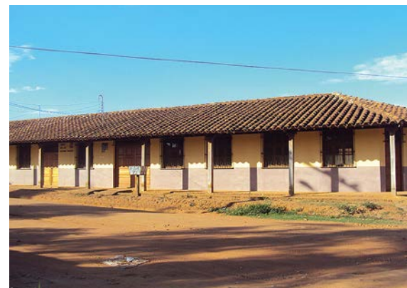
Das neu gestrichene Schulgebäude
