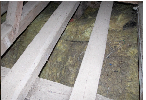
Abb. 27 Dachbodenseitige Isolierung mit Steinwolle (IMG_9404.tif)
