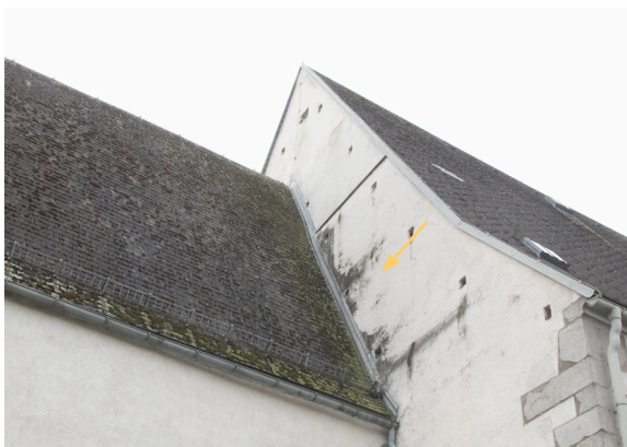
Abb. 08 Dachhaut und bewitterte Ostfassade des Kirchenschiffs (IMG_9446.tif)
