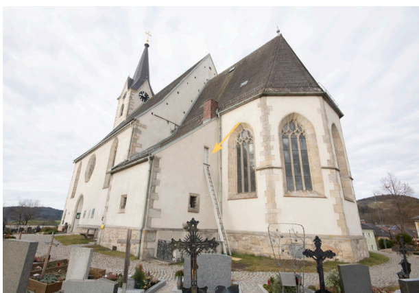
Abb. 03 Blick auf die Ostseite der Kirche mit Sakristeianbau und Einstieg in den Dachbodenbereich zur Wandmalerei (IMG_9466.tif)
