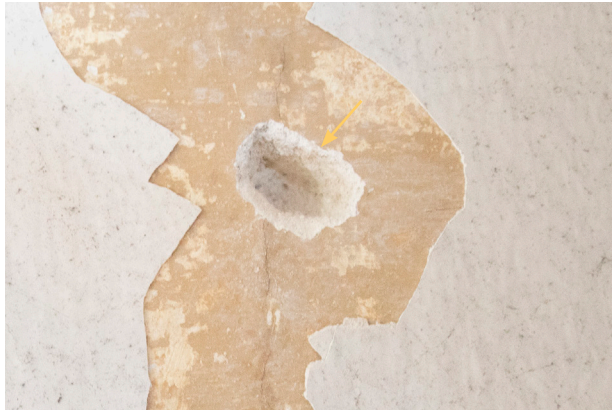
Abb. 31 Spätgotischer Putzaufbau an der Chor Nw, oberes Drittel, Befund 01 (IMG_9497.tif)
