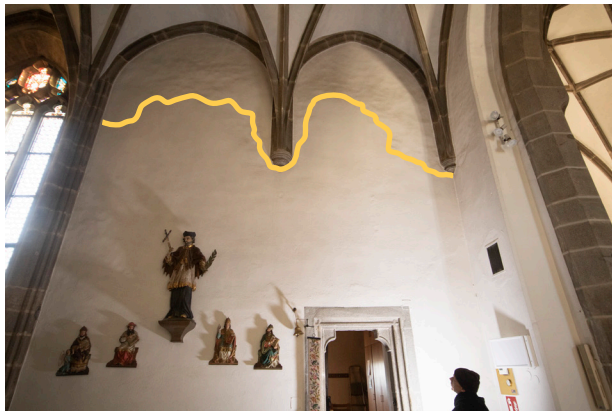
Abb. 33 Putzoberflächen im Streiflicht an der Chor SW, gelb eingezeichnete Grenze von spätgotischem zu stärker geglättetem späteren Putzoberfläche (IMG_9503.tif)
