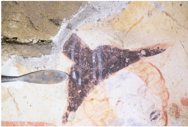
Abb. 49 Rinnspuren eines Hinterfüllmediums (IMG_9417.tif)
