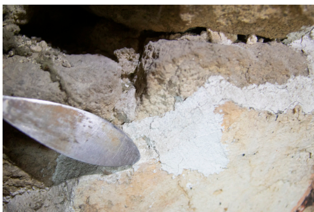
Abb. 48 Optisch unpassende Anböschung (IMG_9426.tif)
