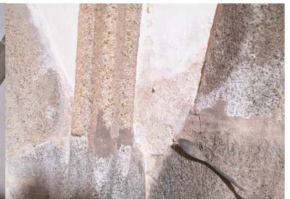
Abb. 19 Salzsäden, Emporengewölbe Detail (IMG_8492.tif)
