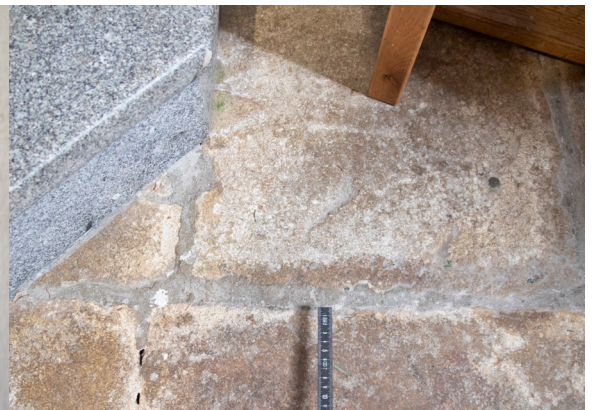
Abb. 25 Zementverfugter Granitplattenboden und Granitfliesen (IMG_9471.tif)
