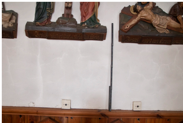
Abb. 43 Holzvertäfelung und Zementputz im Sockelbereich des Kirchenschiffes (IMG_9472.tif)
