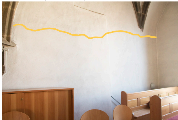
Abb. 44 Rezente Putzergänzung auf Orgelemporen Westwand (IMG_9517.tif)
