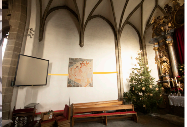
Abb. 15 ChorNw mit Zementputzsockelhöhe (IMG_9480.tif)
