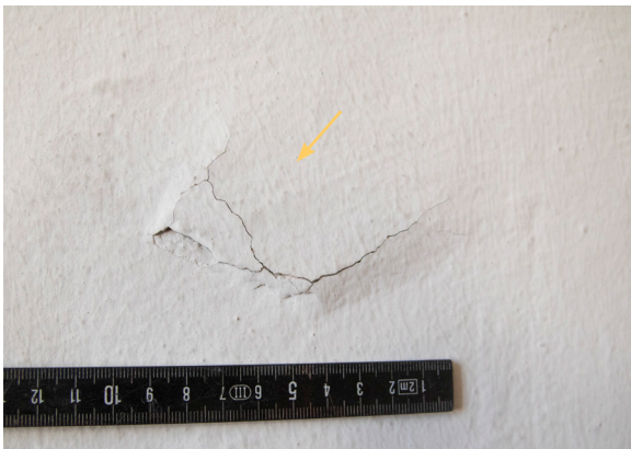
Abb. 24 Plattenbildung des Überriebs (IMG_9520.tif)
