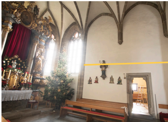
Abb. 16 ChorSw mit Zementsockelputzgrenze, Zement (IMG_9481.tif)
