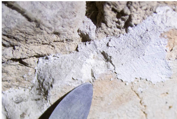
Abb. 37 Putzaufbau des Wandmalereifragments im Dachbodenbereich (IMG_9437.tif)
