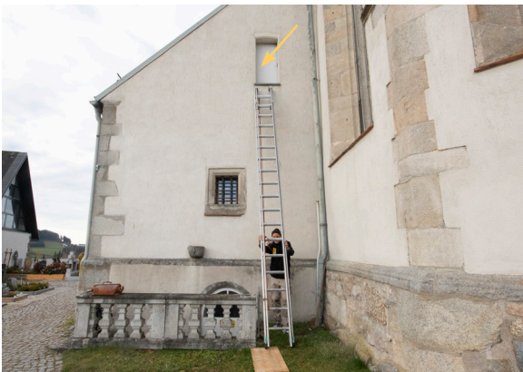
Abb. 28 Einstieg in den Dachbodenbereich des Sakristeianbaus (IMG_9413.tif)
