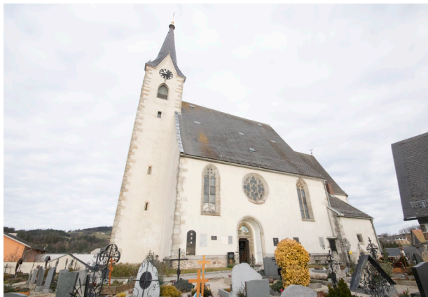
Abb. 02 Westseitiger Blick auf die Kirche (IMG_9463.tif)
