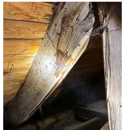
Undichtes Dach
