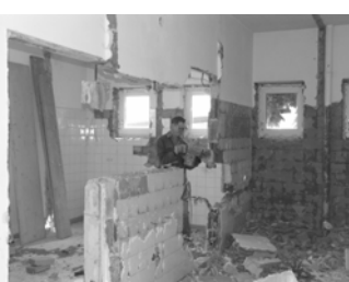
Abbrucharbeiten im WC
