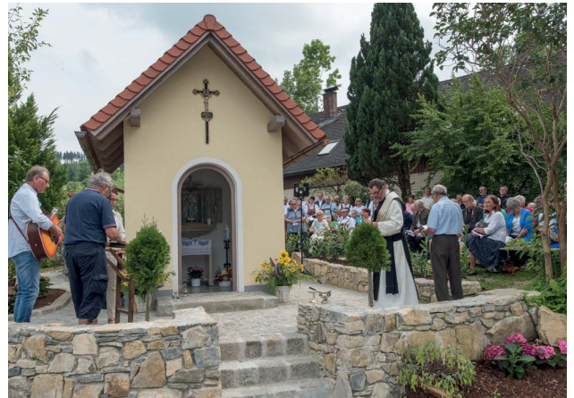
Die Habingerkreuz-Kapelle steht am Wegrand entlang der Schlierbacher Landesstraße bei der Kreuzung zum Grillparz.
