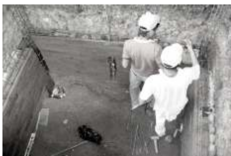
Bau des Auffang-Beckens für die Wasserversorgung...
