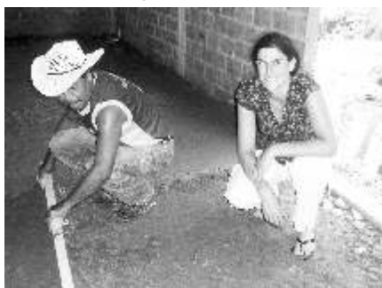
...der Boden in der Kreativschule Los Llanos de Santiago wird betoniert...
