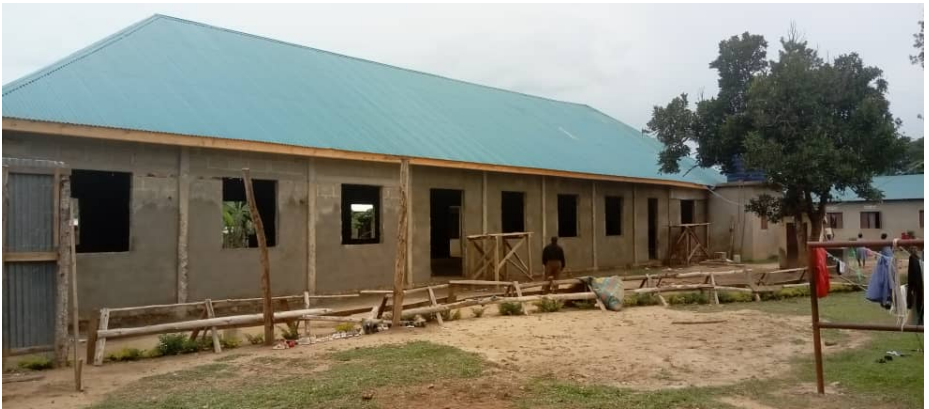
Die Fertigstellung des Auspeisungssaales ist voll im Gange...
