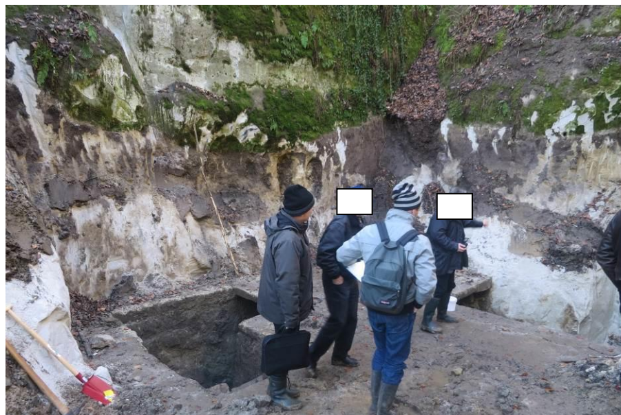
Foto Bundesdenkmalamt: Öffnungen der Betondecke der Aufzeigerdeckung (links Stiegenabgang, rechts Aufzeigerdeckung selbst)
