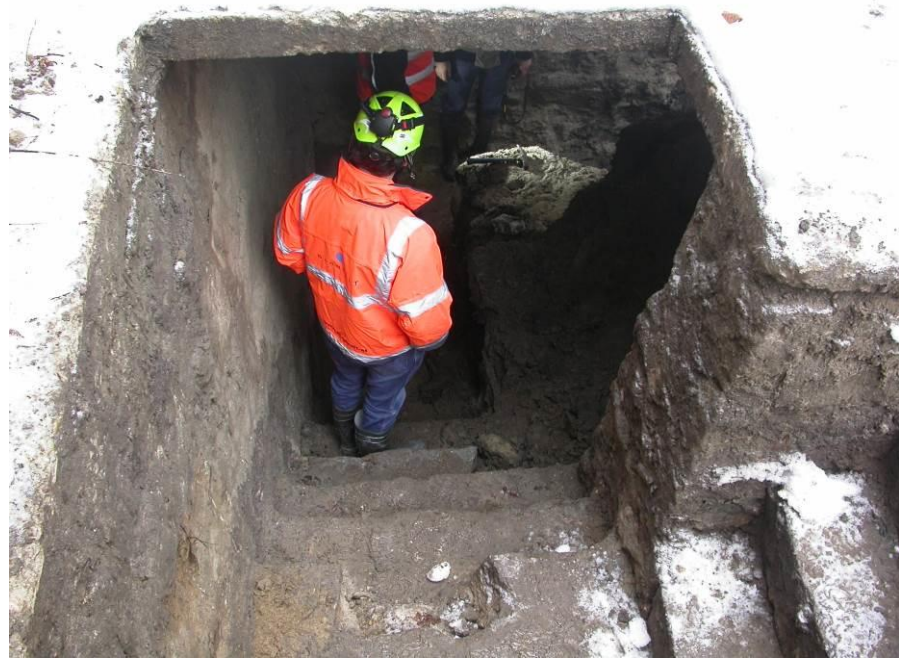
Foto BH Perg: Abgang in die Aufzeigerdeckung
