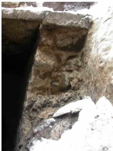
Foto BH Perg: Die rückwärtige Mauer der Aufzeigerdeckung wurde bei den Bagge- rungsarbeiten leider nachhaltig zerstört.
