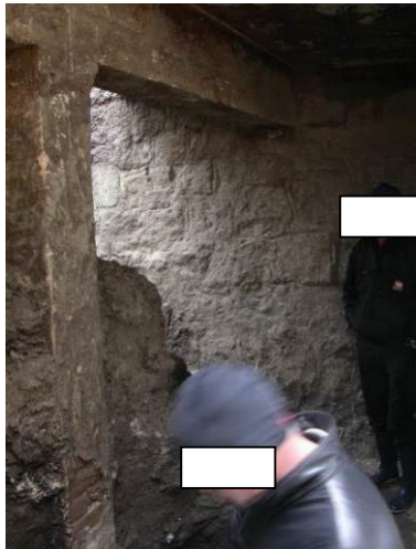
Foto BH Perg: im Inneren der Aufzeigerdeckung
