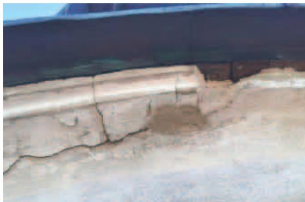
Westseite, Dachgesimse Notsicherung mit Kalkmörtel
