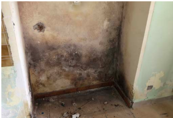
Hinter Holzvertäfelungen hat sich der Schimmel ausgebreitet. Der nächste Schritt ist das Abschlagen des Verputzes und das Trocknen des Mauerwerks.
