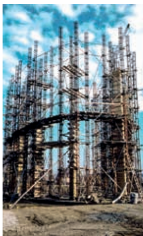
Bewehrung des Betongerippes
