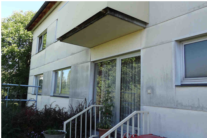
Westfassade des Pfarrhofes
