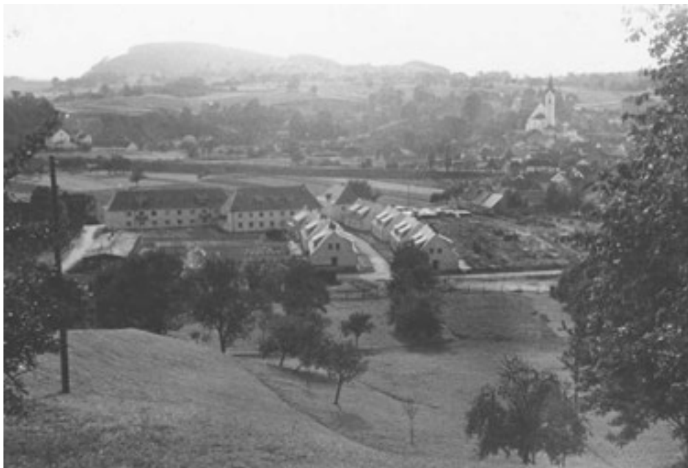
Die sogenannte SS-Führersiedlung und die Gebäude der DEST-Werkgruppenleitung in St. Georgen/Gusen um 1942. Quelle: Heimatverein St. Georgen, Sammlung Franz Walzer
