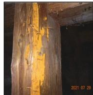
„Die tragenden Alt-Hölzer des Dachstuhles (Hölzer, die bei der Sanierung um 2000 nicht ausgetauscht wurden) zeigen örtlich teilweise starken Wurmbefall auf. Die vorhandenen Mauerbänke sind in gutem Zustand. Allgemein weist der Dachstuhl teilweise Schiefstellung auf. Stuhlsäulen sind bis zu 5° zur Vertikalen geneigt. Auch sind durch die vorgefundene Schiefstellung Holzverbindungen gelöst.“
