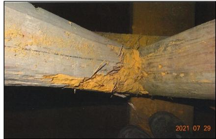
Der konstruktive Dachstuhl weist aufgrund der Schiefstellung grobe statische Mängel auf. Demzufolge sind umgehend Maßnahmen zu treffen. Aus wirtschaftlicher Sicht wird eine Teilsanierung des Dachstuhles unter Beibehaltung der Sparren, Zangen und der Dachdeckung vorgeschlagen. Eine etappenweise Sanierung der vereinzelt Balken, aller Stuhlsäulen, Streben und Kopfbänder sollte aus technischer Sicht möglich sein.
