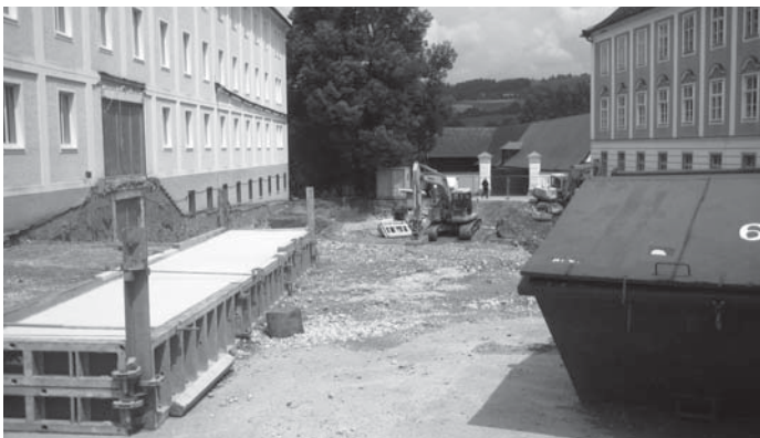
Der neue Turnsaal entsteht
