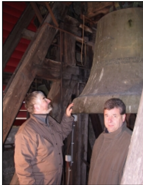
Glockenreferent Adlberger mit Stefan Übellacker bei der Beurteilung des Zustandes von Glocken und Läutwerk
