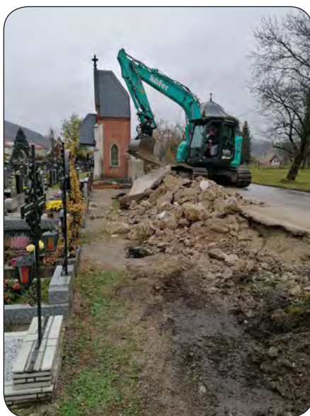
Abbruch der alten Friedhofsmauer
