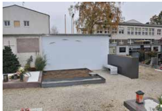
Projekt „Rückkehr“ kurz vor der Fertigstellung
