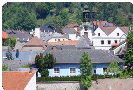
Die vorgesehene Dachfläche für die PV-Anlage
