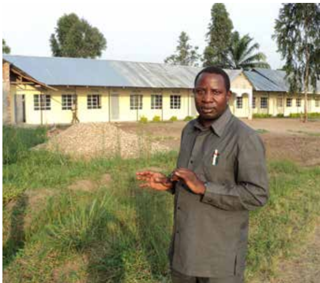
P. Athanasius während der Schulbauarbeiten Foto: P. Dr. Athanasius Mutasingwa
