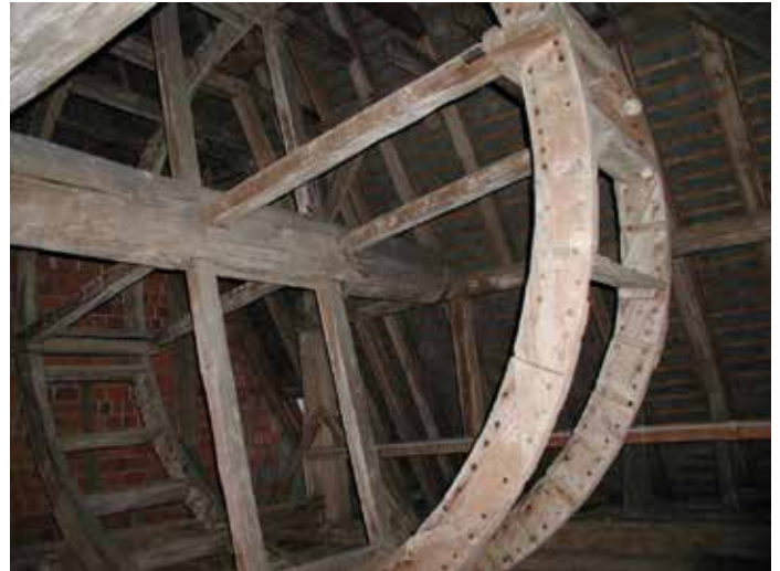
Tretkran auf dem Kirchendachboden
