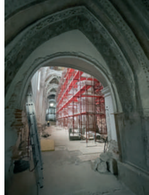
Durchbruch vom Luthaus zum nördlichen Seitenschiff, Foto: P. Josef Stelzer
