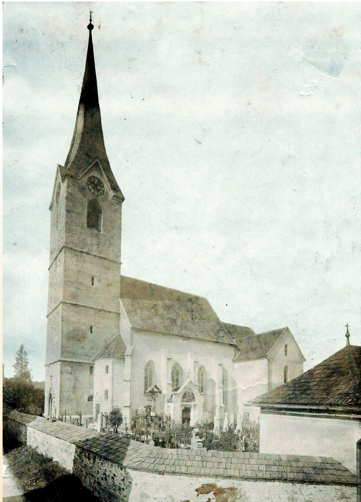
Alte Ansicht mit Mauer, 1925
