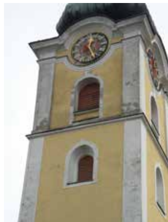
Risse und schadhafter Putz
