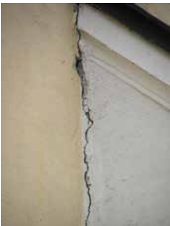
Risse und schadhafter Putz
