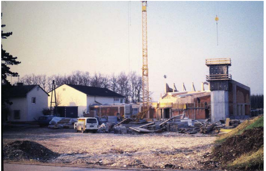
Kirchen-Baustelle in Oedt
