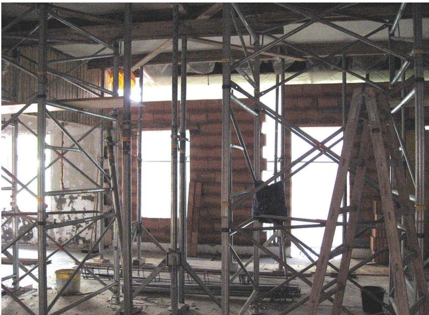
Abb. 34: Unterstellung des Dachstuhles aufgrund der morschen Wand, 22. 8. 007
