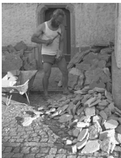
Foto: Rudolf Hagenauer (1992, Baustelle)
