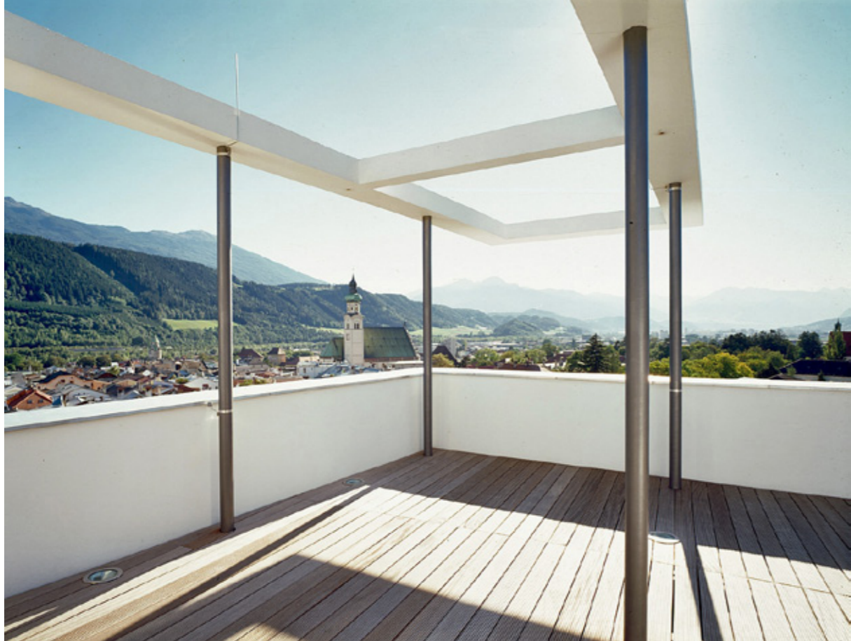
Margherita Spiluttini: Ehemaliges Turmhotel Seebes, Lois Welzenbacher, Um- und Zubau, Henke und Schreieck Architekten, Hall in Tirol, 2003 © Margherita Spiluttini, Courtesy: Künstlerin und Christine König Galerie, Wien.
