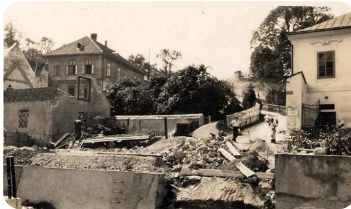
„Baustelle“ vor dem Pfarrhof
