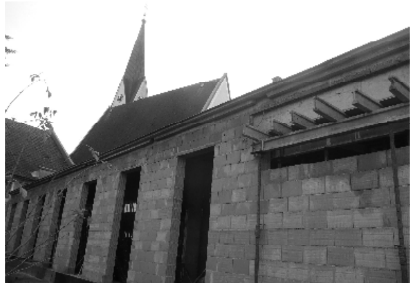
Der Rohbau während des Winters
