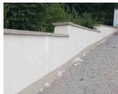
Frostschäden Friedhofsmauer
