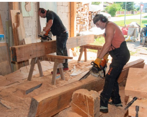
Stefan und Michael schneiden die Balken für den Taufort zu.
