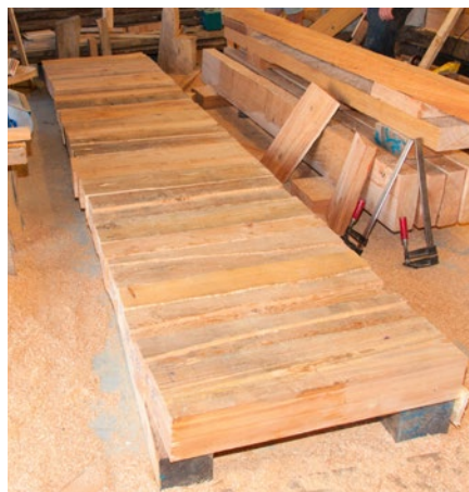
Die Elemente der Emporebrüstung im Rohzustand
