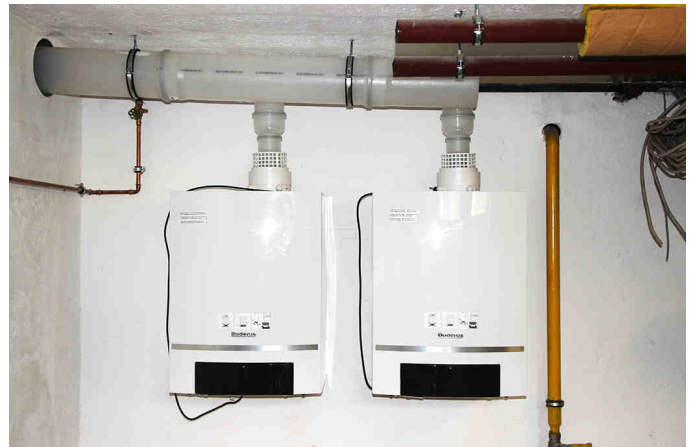
Gasthermen sind eingebaut
