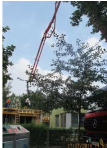
Beton, direkt vom Himmel?
