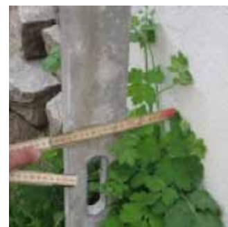
Baustelle Foto: privat
