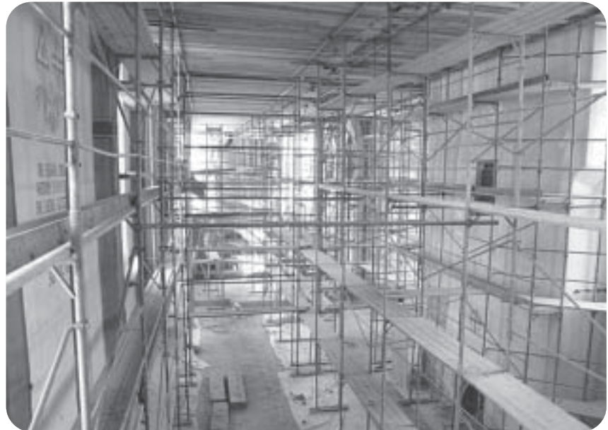
Und jetzt? - Alles Baustelle!
