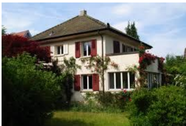
Einfamilienhaus im Zelgli-Quartier
