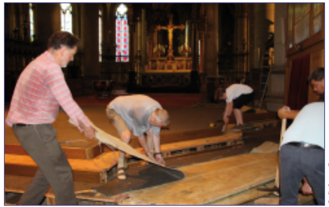
Abbrucharbeiten für den neuen Altarraum - durch Helfer aus der Dompfarre
